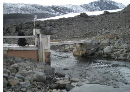
Figure 36 : La station Rännan (colonne de gauche) et la station Lillsjön (ci-dessus) – Source : Station de recherche de Tarfala
